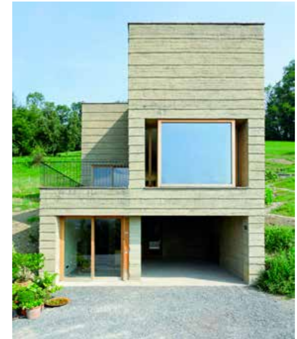
Wohnhaus Martin Rauch in Schlins
