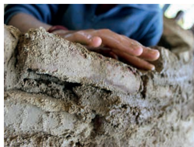
Lehm ist ein Material, das alle Menschen auf dem Globus verbindet – Fertigung der luftgetrockneten Lehmziegel für eine Sichtschutzmauer auf dem Gelände
