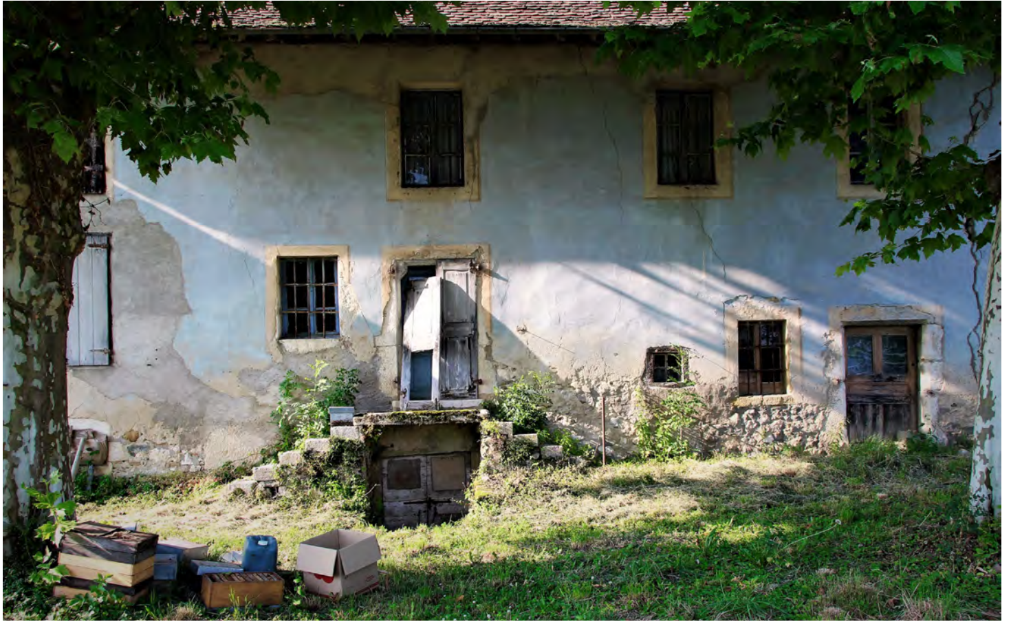
Façade de la maison de ferme
