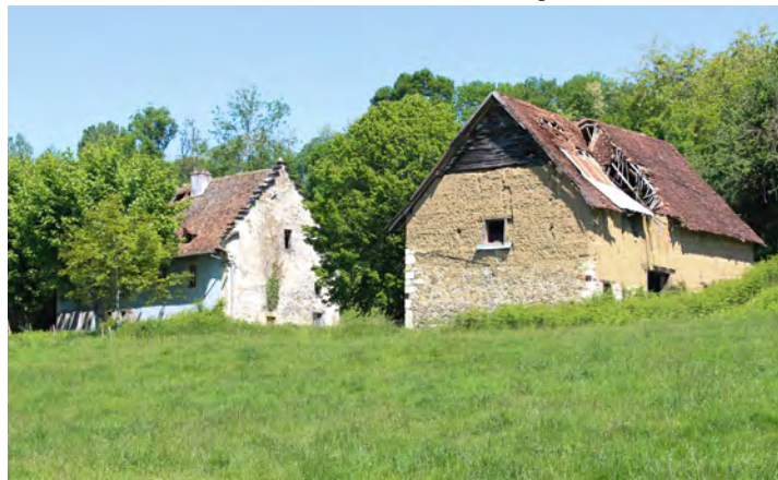
Vue sur la ferme côté sud-est
